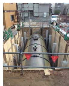
●燃料タンク増設の様子
