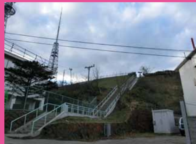
▲室蘭送信所の跡地。今までお世話になった感謝を込め、撤去工事を行いました。
