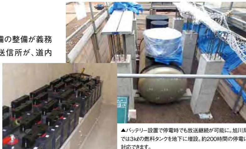
▲バッテリー設置で停電時でも放送継続が可能に。旭川局では3kℓの燃料タンクを地下に増設。約200時間の停電に対応できます。
