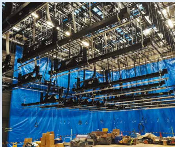
放送・通信関連機器の設置工事が進んでいます。4月30日、第1スタジオに照明パトンを設置。一気にスタジオらしい雰囲気。
