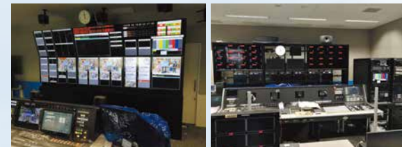
マスター機器の更新作業も、社屋移転と同時に進めています。4月には、放送の心臓部といえる主調整室(マスター)のシステムの電源を入れる「火入れ」を行いました。副調整室(サブ)の各機器の電源も入れました。
